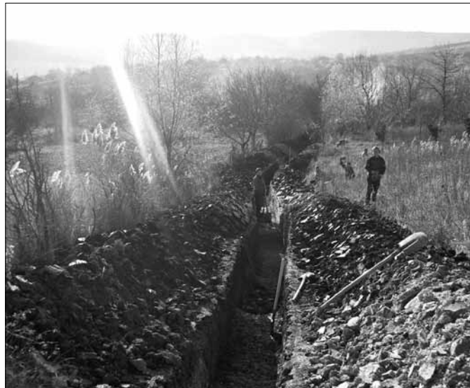
Lucrările de săpare a tranșeei pentru apeduct
